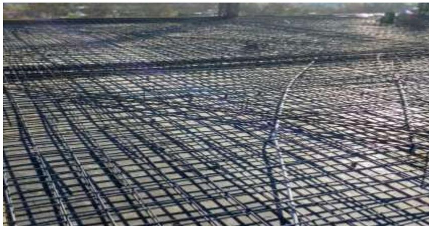
Figura 15: armado de losa y cañería eléctrica sobre 7° P.
