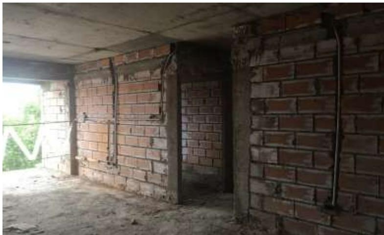
Figura 30: bocas y cañerías de alta y baja tensión
