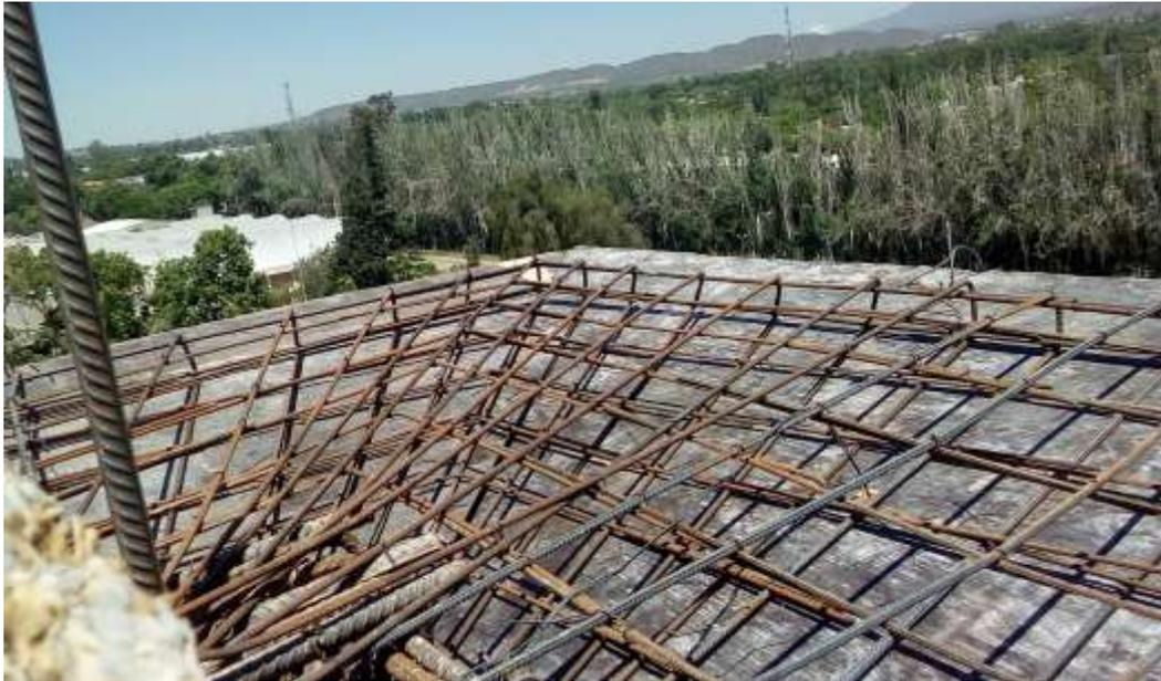
Figura 23: armadura de alero en ultimo nivel
