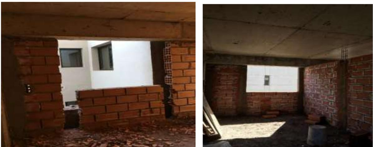
Figuras 40 y 41: CE enmarcando a aberturas, agregadas según lo exigía plano estructural
