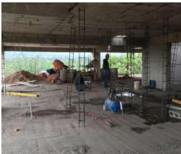
Figura 37: control de dimensione y ubicación de CE
