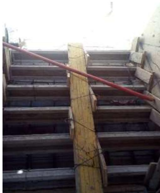
Figura 20 y 21: armado y encofrado de escaleras del último nivel.
