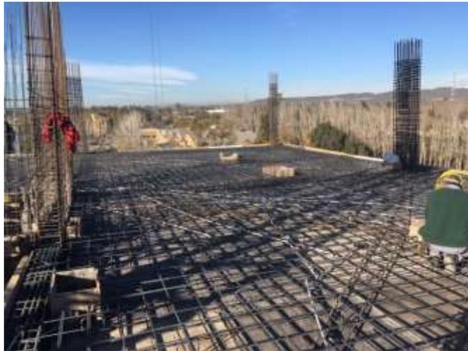
Figura 33: Armadura en losa y vigas
