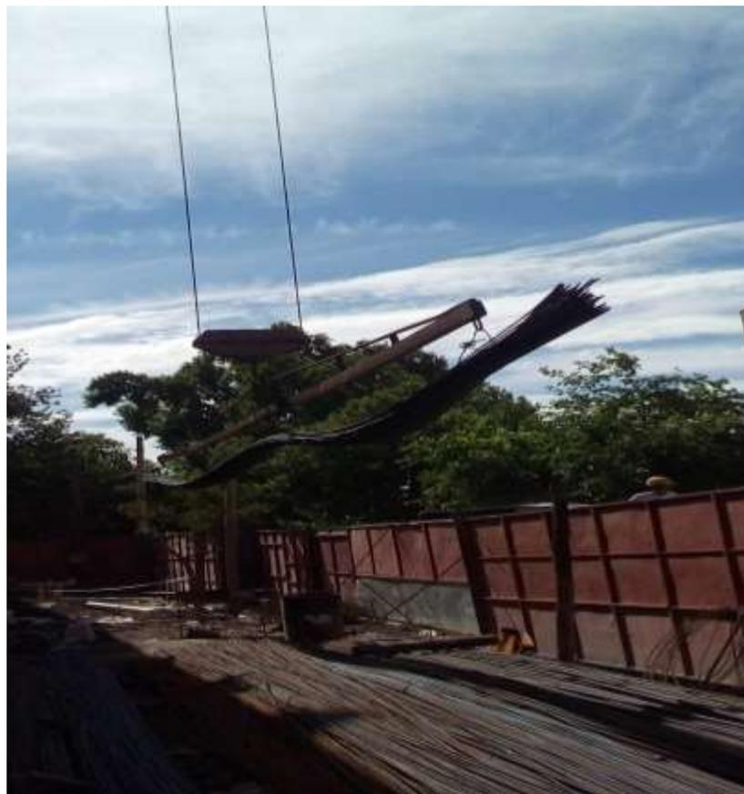
Figura 11: Transporte de hierro hacia el ultimo nivel
