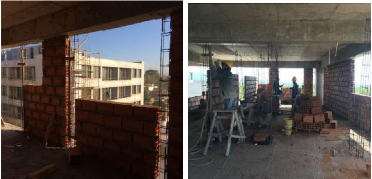
Figura 26 y 27: colocación mampostería y encofrado y colado de CE y VE en últimos niveles.
