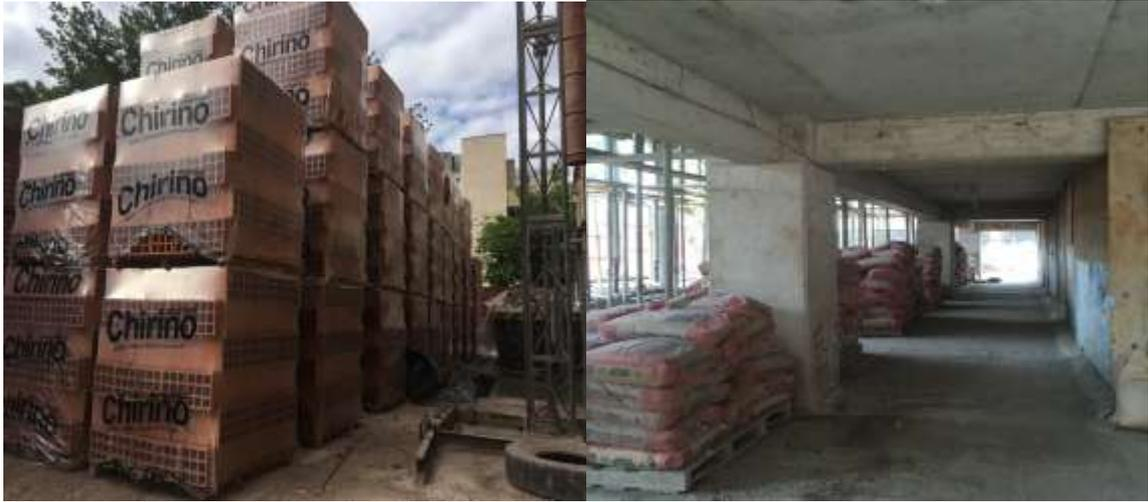
Figura 10: zona de acopio de ladrillos y cemento
