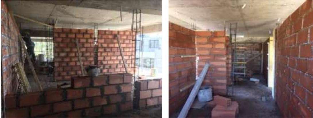
Figura 38 y 39: Control de líneas, escuadras y plomos en muros de mampostería
