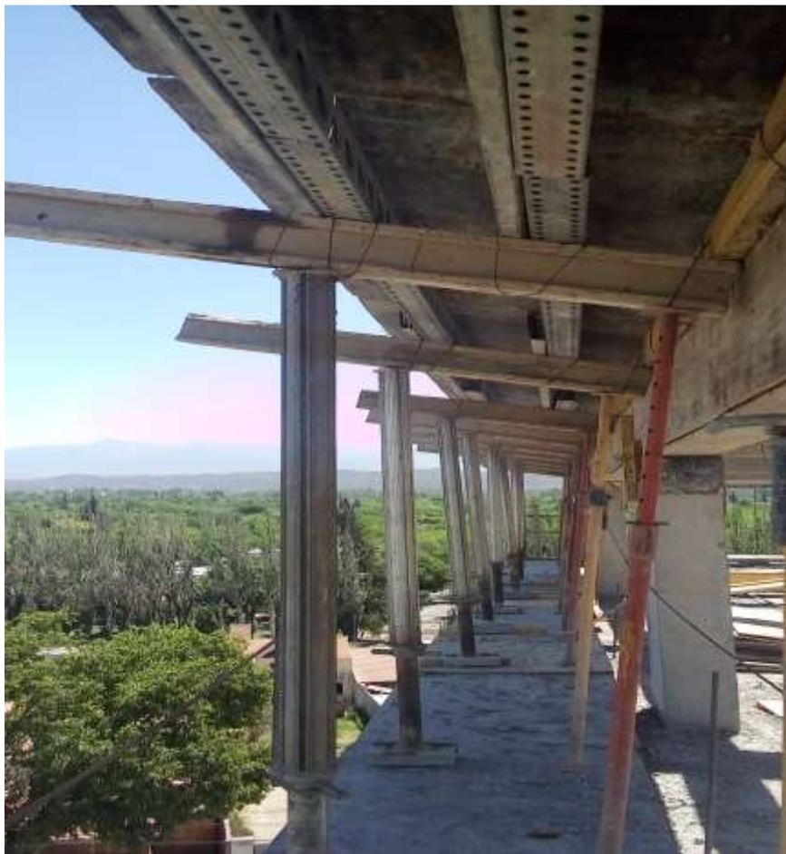
Figura 24: encofrado de alero
