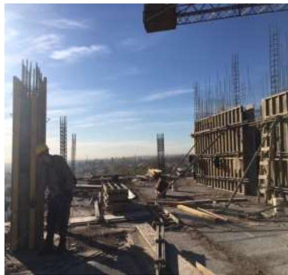
Figura 18 y 19: armado, encofrado y colado de tabiques y columnas de 8°P.
