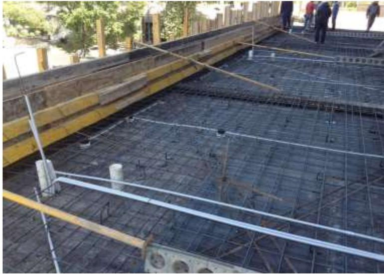
Figura 29: instalación eléctrica sobre losa de locales comerciales
