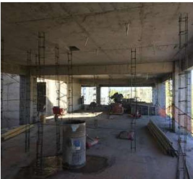
Figura 26: Replanteo, izado de columnas y anclaje a la superestructura
