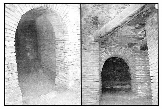
Figura 6. Detalles del interior de CM2 donde se observa el sostén con ladrillos cocidos que revisten tanto paredes externas como internas, así como las vigas de fuertes maderas que sostienen el techo
