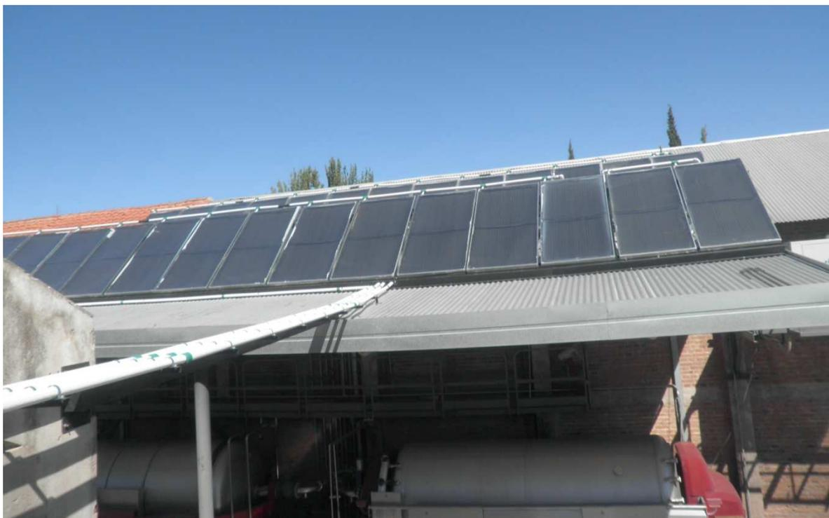
Figura 33 - Colectores solares para agua caliente industrial en Bodega Terrazas <sup>44</sup>
