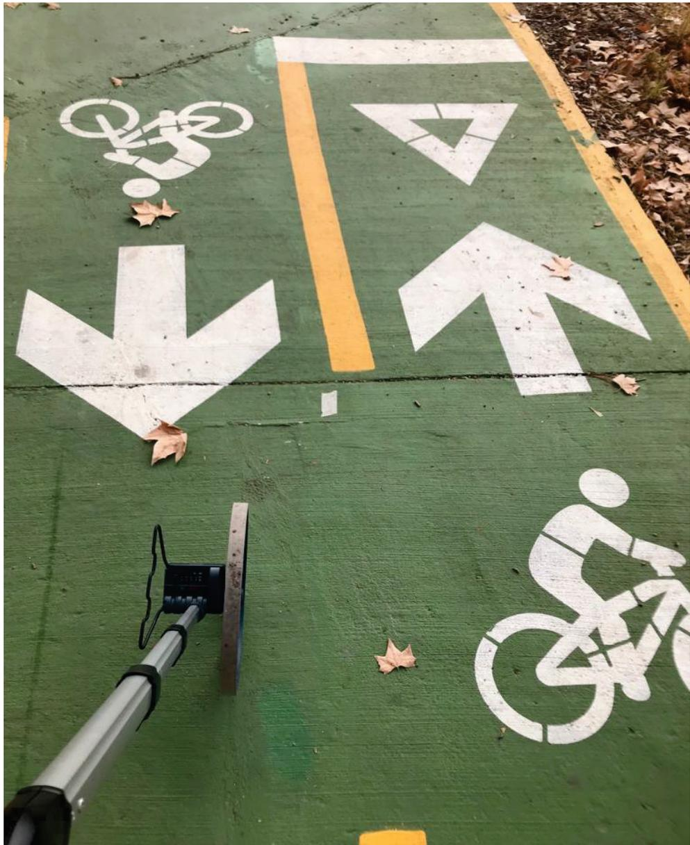
Figura 13. Medición con odómetro de ciclovía terminada y pintada.
