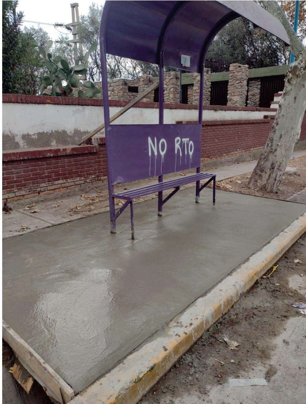
Figura 14. Ejemplo de dársena realizada, medida en unidades de superficie.
