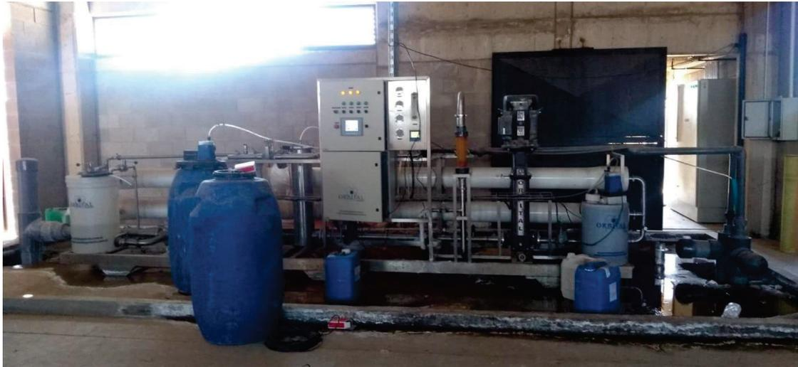
*Figura n° 8. Sistema de osmosis inversa*
