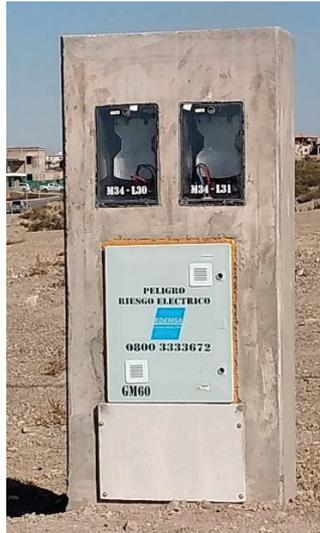
Figura n° 10. Gabinete con medidor
