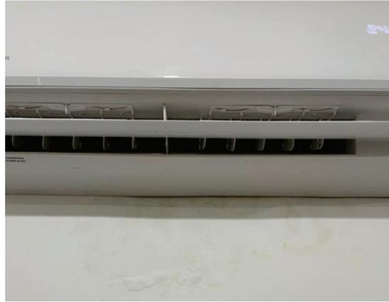
*Figura 74: Presencia de humedad por obstrucción en caño de desagüe*
