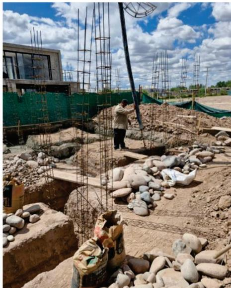
*Figura 40: Colocación de H° elaborado en cimientos y bases con bomba*
