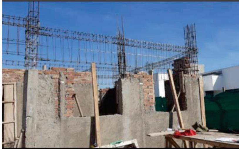
*Figura 43: Armadura de vigas de dintel*
