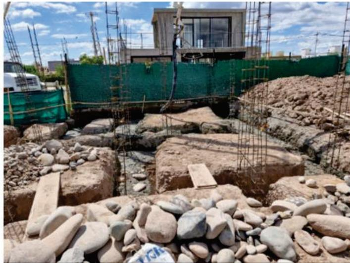
*Figura 41: Colocación de H° elaborado en cimientos y bases con bomba*
