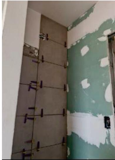
Figura: Replanteo de revestimientos
