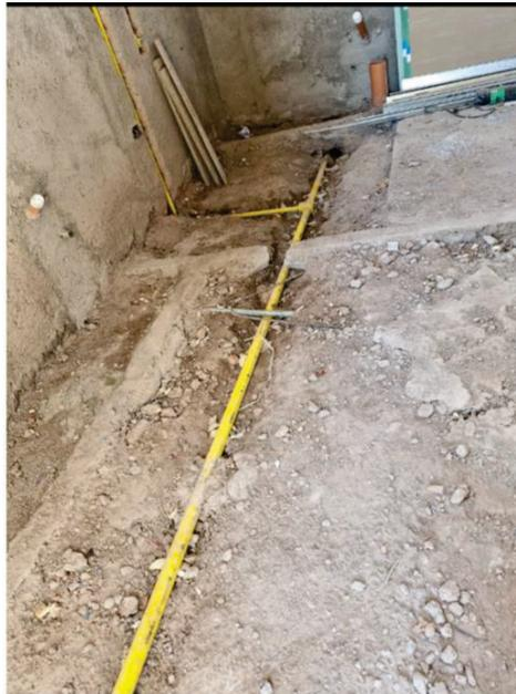
*Figura 51: Instalación de gas*
