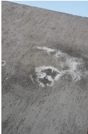
*Figura 73: Presencia de humedad por embudo pluvial mal sellado*
