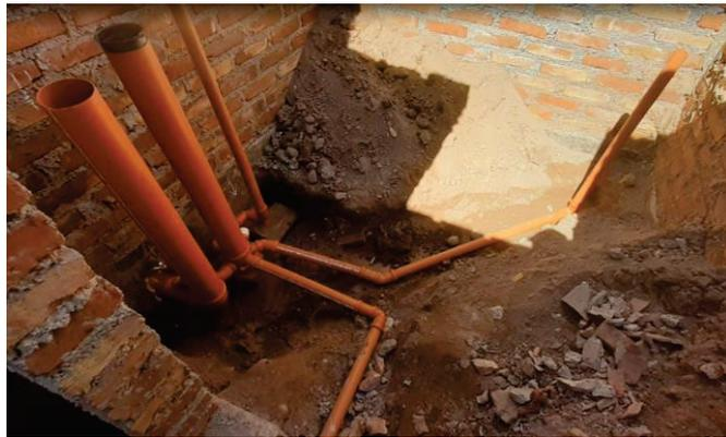
Figura 45: Instalación de cloaca
