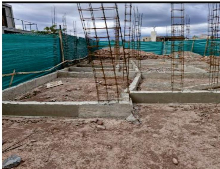
*Figura 42: Vigas de fundación desencofradas*
