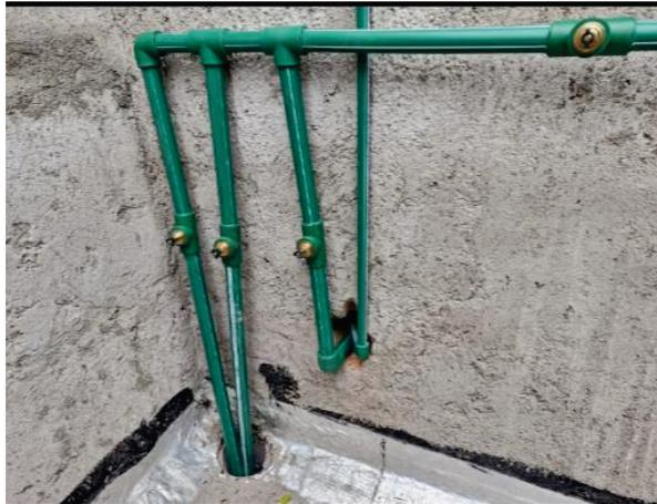
*Figura 47: Instalación de agua en tanque*
