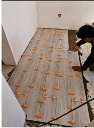
*Figura 65: Replanteo de pisos*
