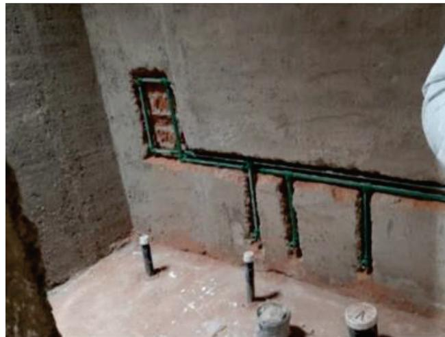
*Figura 49: Instalación de agua en baño*
