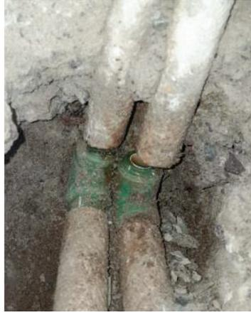
*Figura 72: Caño de agua mal fusionado*
