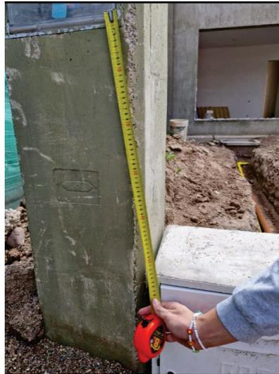
*Figura 50: Distancia mínima de gabinete de gas con respecto a tablero de pilastra 50cm*
