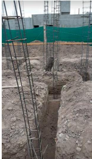
*Figura 39: Armadura de columnas y bases*
