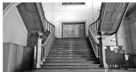
Ilustración 12 Escalera del edificio de calle Lavalle 373
