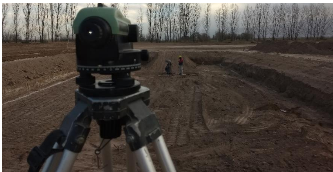
Ilustración 20: Nivelación de estacas en fondo de laguna
