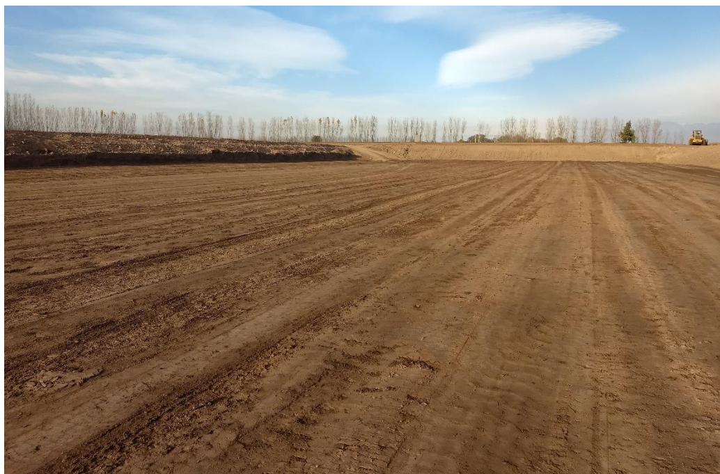
Ilustración 12: Fondo de laguna compactado
