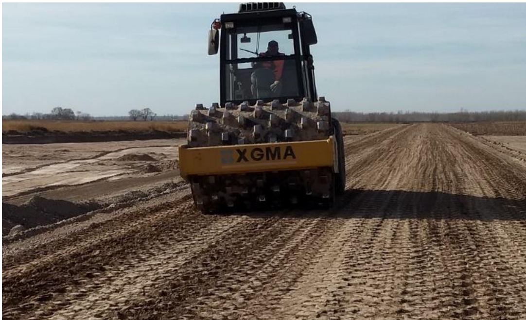
Ilustración 7: Rodillo pata de cabra compactando capa
