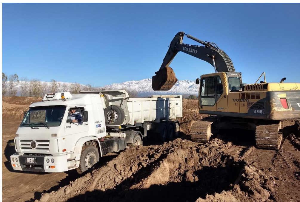
Ilustración 4: Carga de camiones
