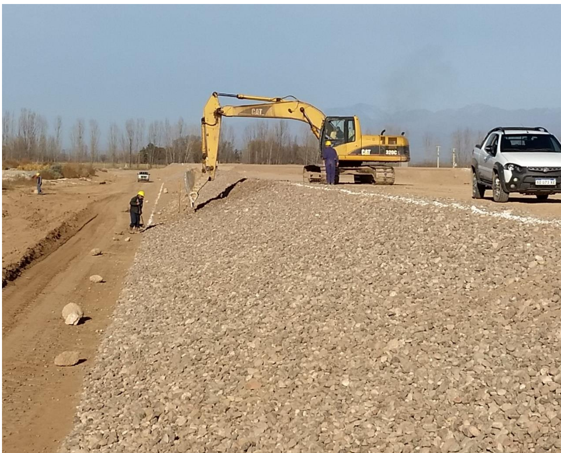
Ilustración 11: Excavadora emparejando rechazo
