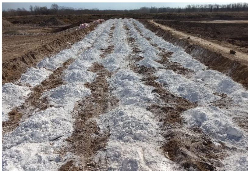
Ilustración 10: Cal previo a mezcla con tractor y rastra
