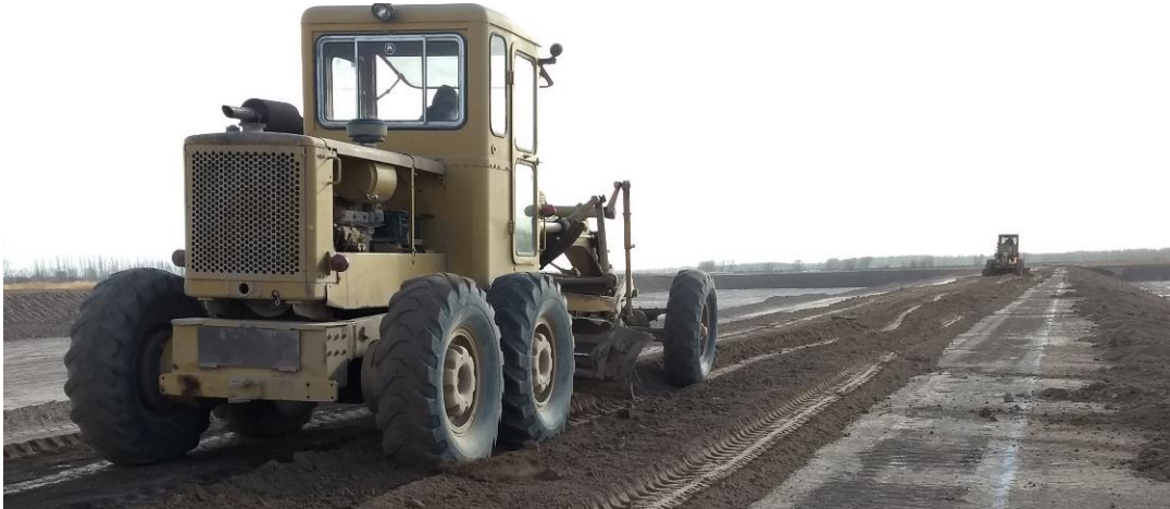
Ilustración 6: Motoniveladoras emparejando material
