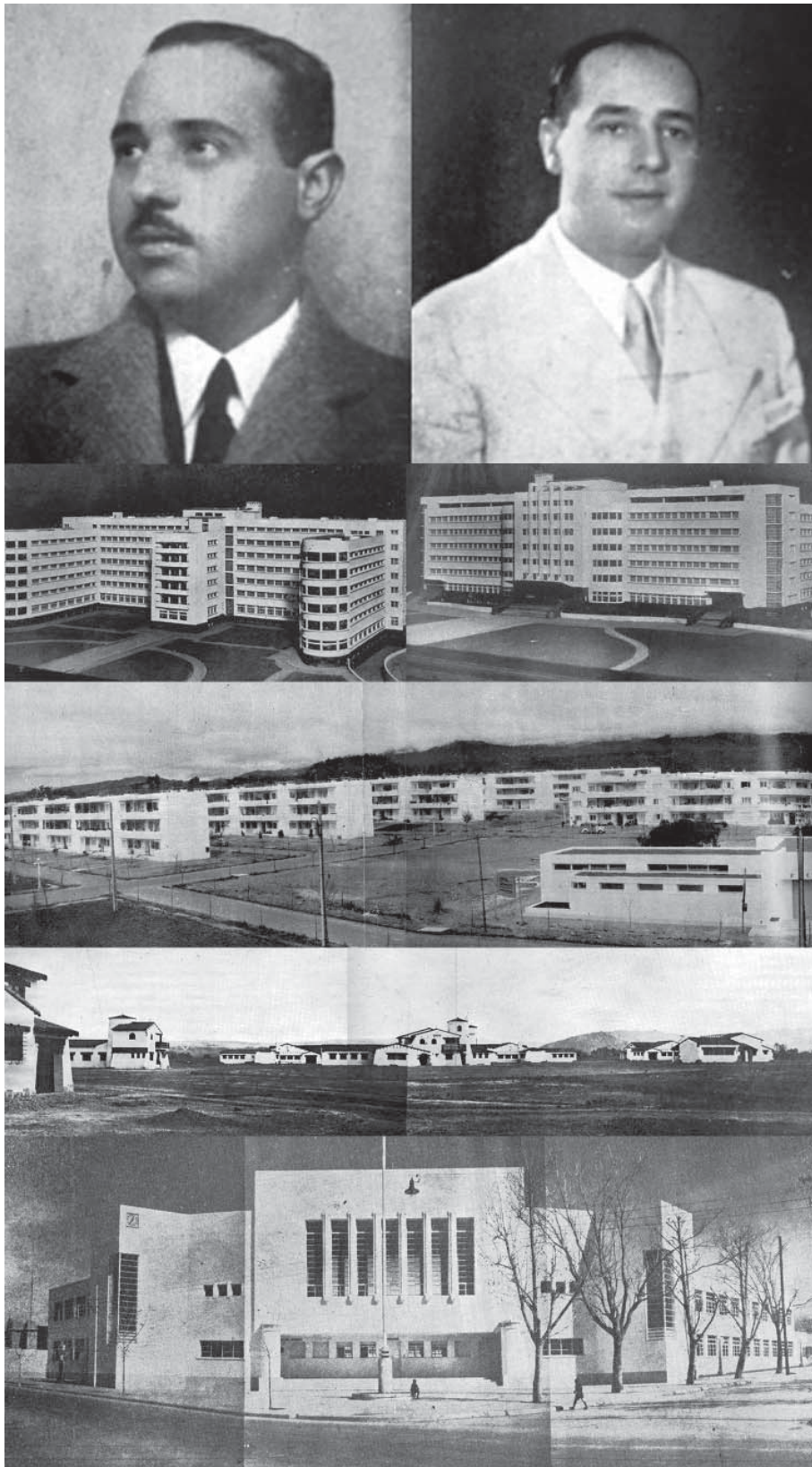
Manuel y Arturo Civit. Obras ejecutadas durante sus gestiones: Hospital Central, Barrio Cano, Colonia para Menores y Escuela Videla Correas. Fuente: Ministerio de Economía, Obras Públicas y Riego. Memorias 1938-1941, tomo VIII.
